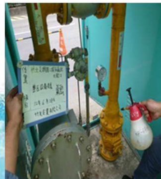
高鐵區嘉政九整壓站 檢測及更新軸流閥
